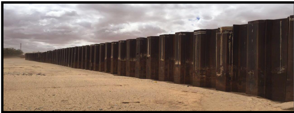
Figure I. 9 : Rideaux des Palplanches métalliques Oued M'ZI.
