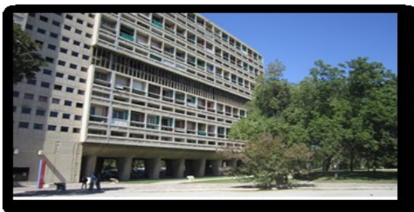
Figure 15 façade libre en béton.
