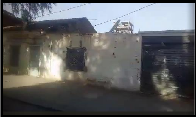
الصورة 44: توضح الواجهة على الطريق الوطني. المصدر: تصوير الطالبة 2021/04/14
