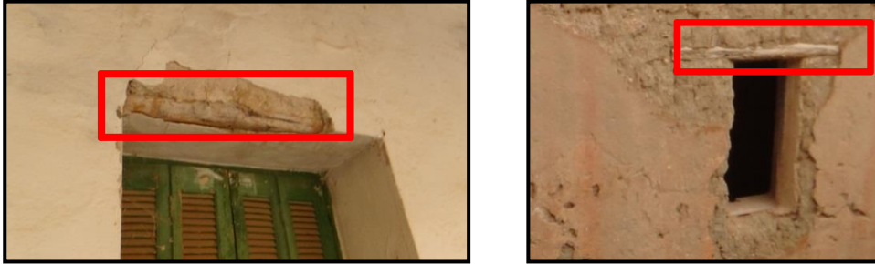
شكل 126: السواكف المستعملة في النوافذ. المصدر: الطالبات
