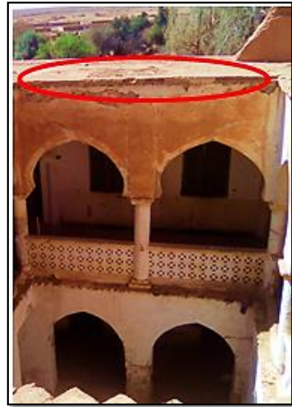
شكل 137: تآكل أعلى الجدار
