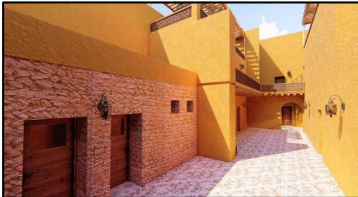
شكل 185: اعادة بناء الجدار بتقنية السنبلة. المصدر : الطالبة
