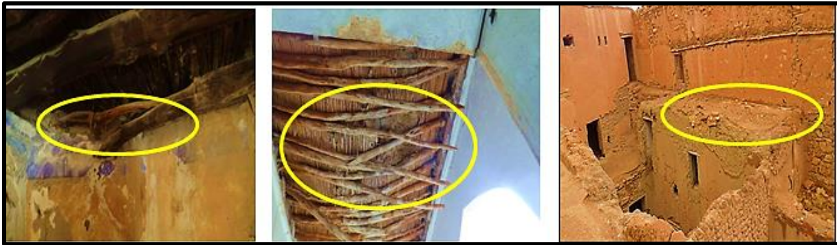
شكل 188: توضيح مختلف عوامل تلف السقف
