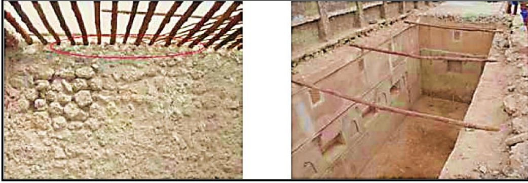
شكل 27: تظهر أحد أسقف غرف بيت الشيخ سلمان بعد إزالة السقف شكل 28: طريقة صف العوارض الخشبية المصدر: المرجع السابق
