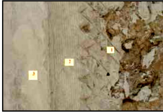
شكل 36 : توضيح طبقات الملاط الثلاث لترميم بيت الشيخ سلمان
