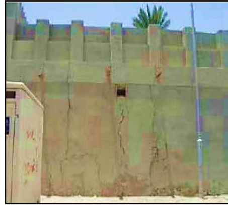
شكل 25 : توضيح الواجهة الجنوبية مغطاة بالإسمنت شكل 26 : توضيح عملية إزالة الإسمنت المصدر: المرجع السابق
