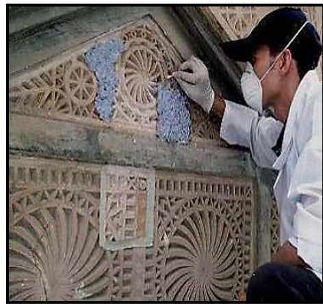
شكل 34 : عملية التنظيف بالكمادات والقطن
