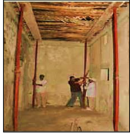
شكل 23 : تدعيم الأسقف لأحد الغرف في بيت الشيخ سلمان شكل 24 : تدعيم جدران لأحد الغرف في بيت الشيخ المصدر: المرجع السابق
