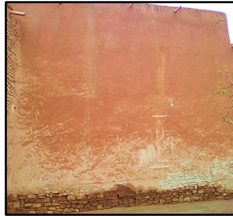
شكل 162: تآكل الاساسات المصدر : الطالبة
