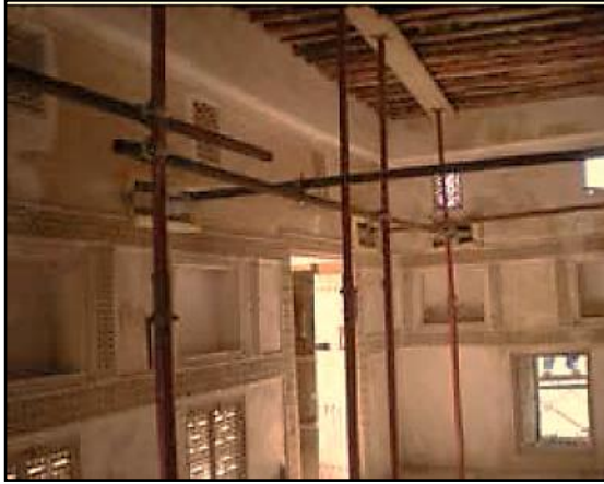
شكل 23 : تدعيم الأسقف لأحد الغرف في بيت الشيخ سلمان شكل 24 : تدعيم جدران لأحد الغرف في بيت الشيخ المصدر: المرجع السابق
