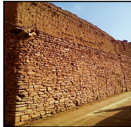
شكل 66: صورة تبين واجهة بالحجارة والطوب
