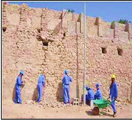
شكل 25 : توضيح الواجهة الجنوبية مغطاة بالإسمنت شكل 26 : توضيح عملية إزالة الإسمنت المصدر: المرجع السابق
