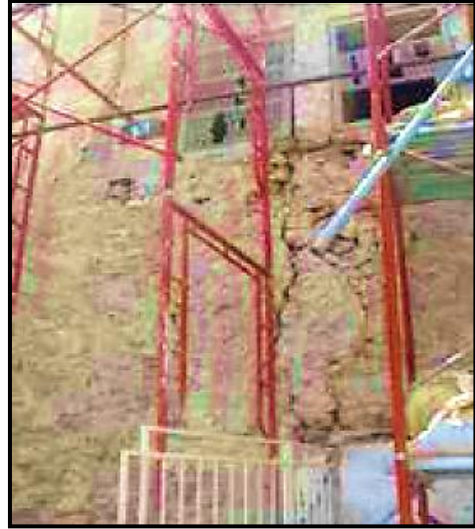
شكل 32: مظهر لشرخ بعد إزالة طبقات الكساء
