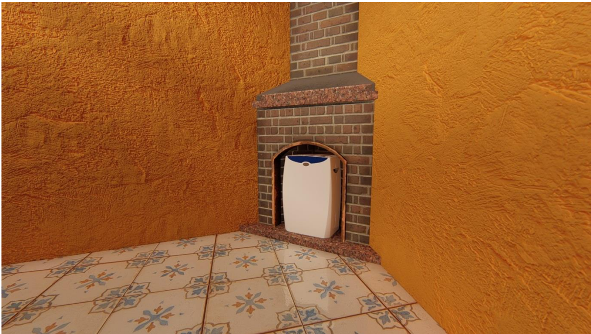
شكل: 217 صورة تبين دمج المكيفات الهوائية في الجدار المصدر: الطالبة
