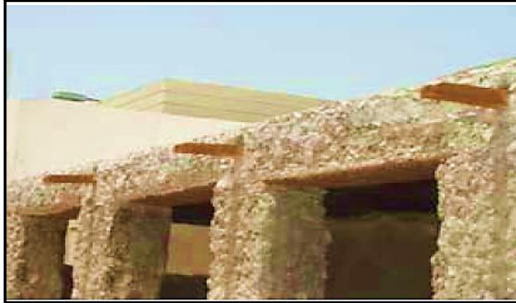
شكل 29: طريقة وضع (عُصي لبامبو وحصيرة المنغور) شكل 30: الطبقة العلوية للسقف مع عوازل المطر والحرارة المصدر: المرجع السابق
