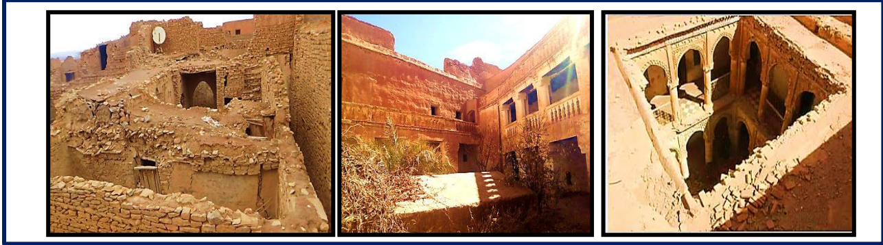
شكل 76: توضيح الشكل الداخلي لبعض المنازل بقصر عين ماضي
