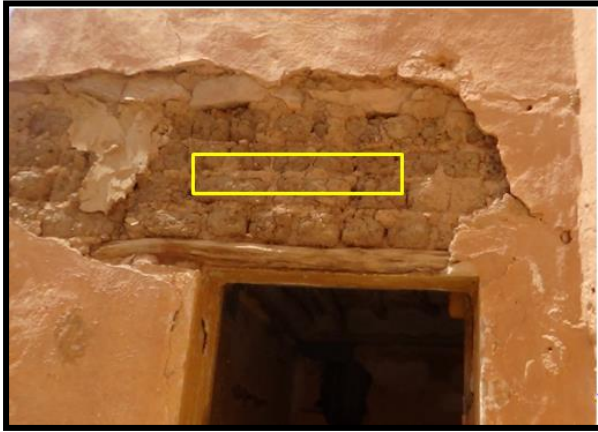
شكل 121: صورة توضح الملاط المصدر : الطالبات
