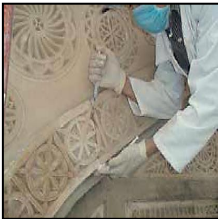
شكل 35: توضح عملية حقن المادة المقوية في الشروخ
