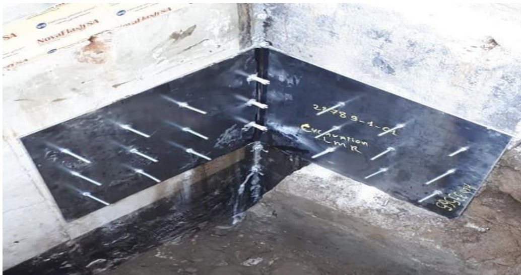
Figure III-5 : La mise en place d'un coffrage étanche.
