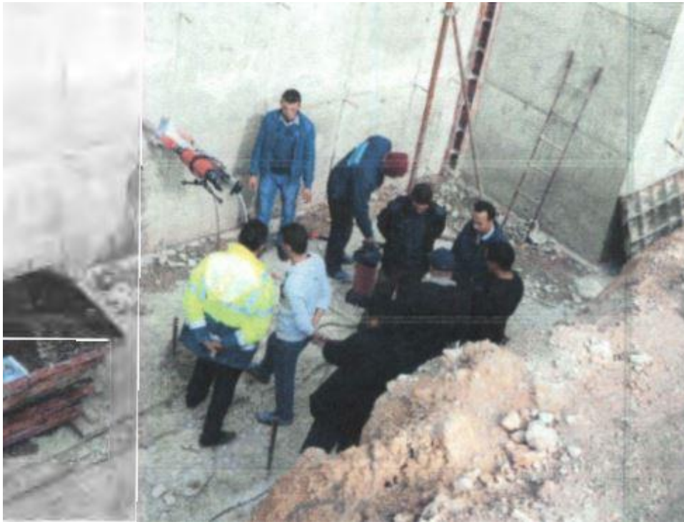
Figure III-4 : Prélèvement des carottes de Culée 12 Droite.
