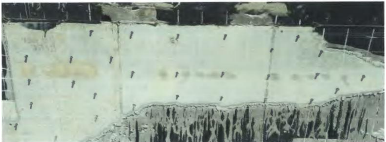
Figure III-6 : Mise en place des injecteurs en respectant l'espacement E < 30 cm.
