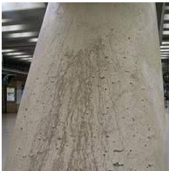
Figure I-5 : le phénomène de veines de sable.[14]
