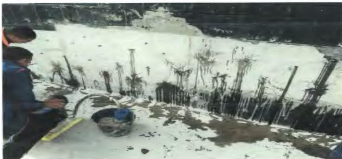
Figure III-7 : Injection des résines.
