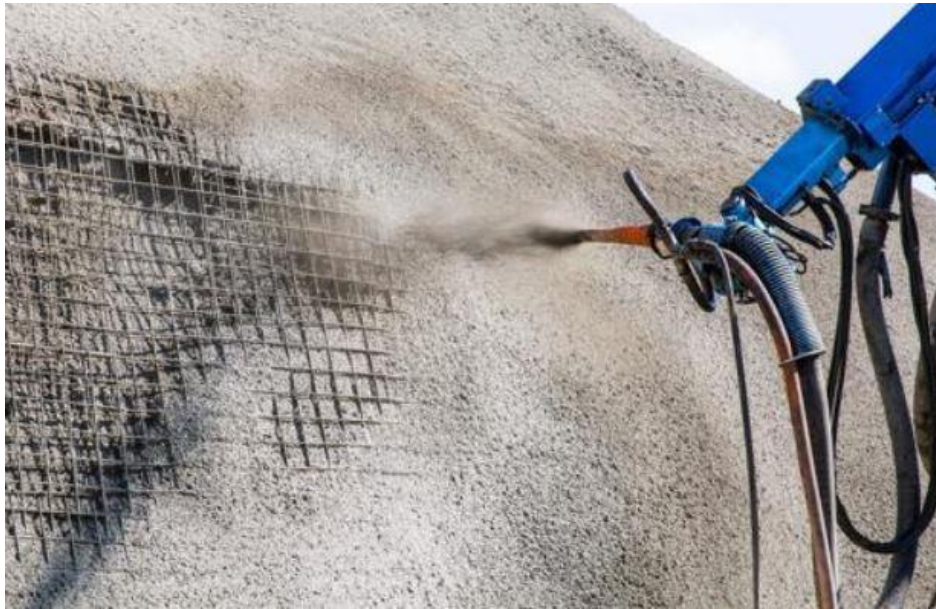
Figure II-3 : Le béton projeté.
