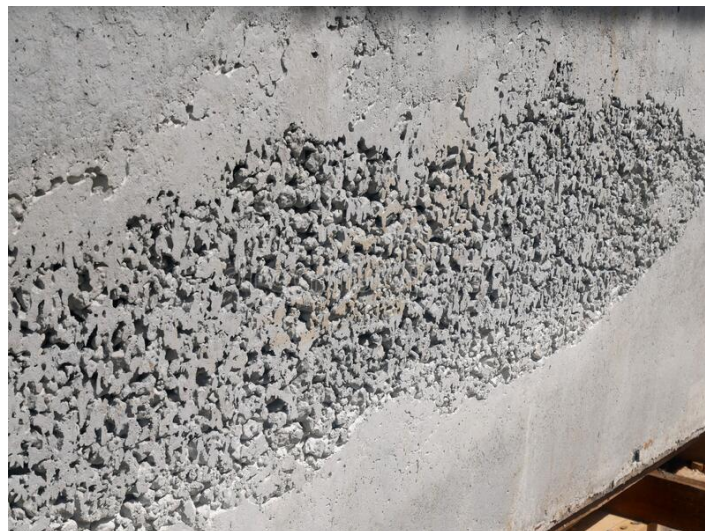
Figure I-3 : le phénomène du nid de gravier.[1]
