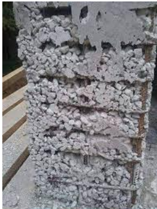
Figure II-1 : Phénomène de ségrégation.
