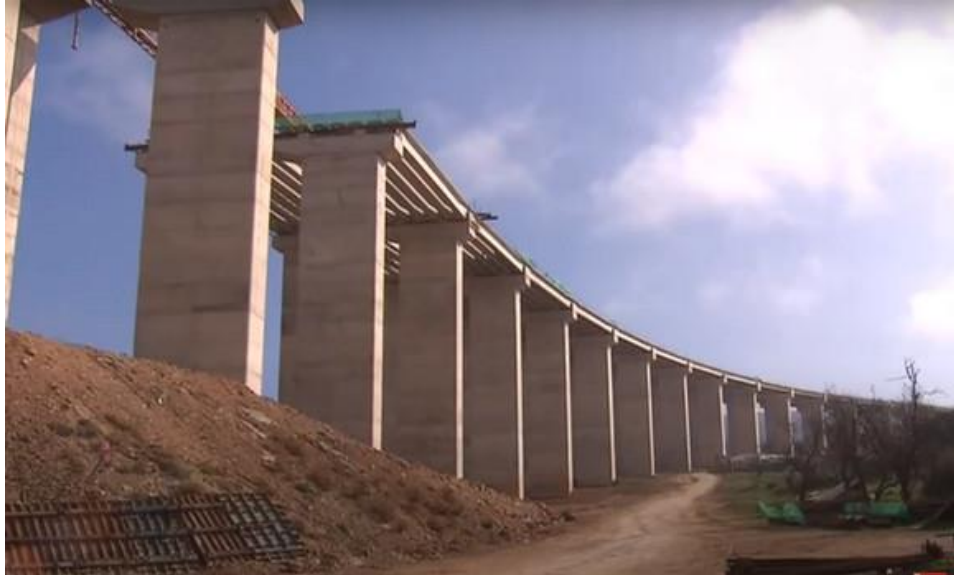
Figure III-2 : Vue du Viaduc
