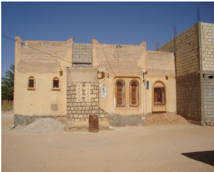
Figure V.4 : Vue sur la façade Est.
