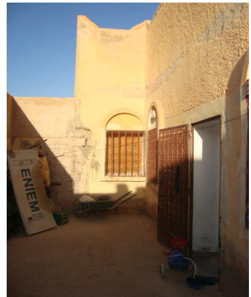
Figure V.5 : Vue sur la façade Ouest.
