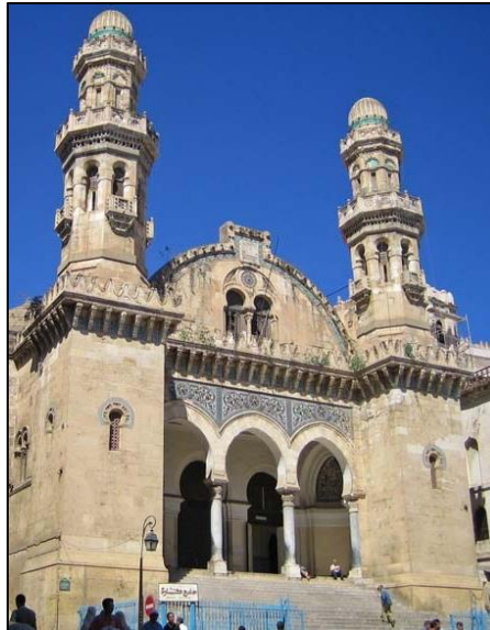
صورة 1- واجهة جامع كتشاوة قبل عمليات الترميم (ويكيبيديا)
