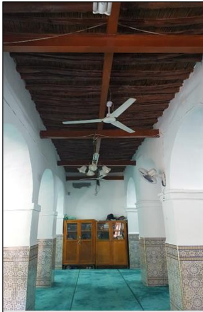
صورة 14- مسجد التاوتي (الباحث)
