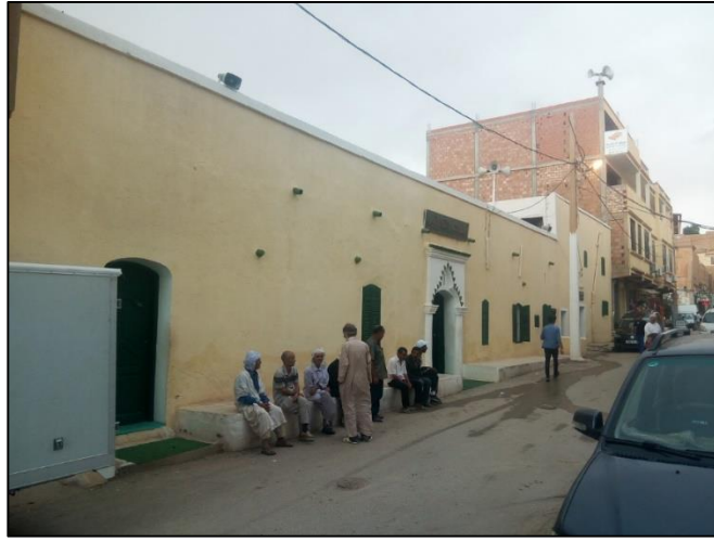
صورة 12- مسجد التاوتي (الباحث)
