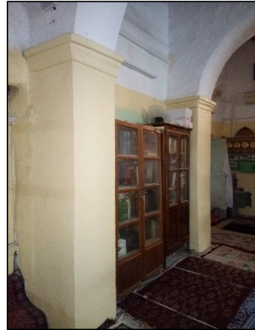
صورة 27- أعمدة وحائط المسجد (الباحث)
