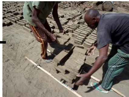
Figure 48 : déplacement des blocks de brique
