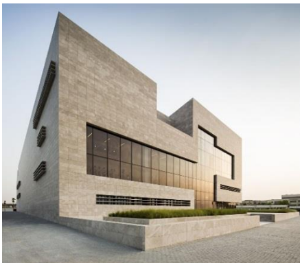
Figure 65 : Vue de façade principale Source : archidaily
