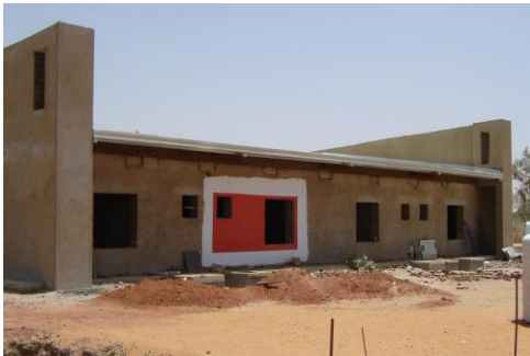
Figure 49 : les murs extérieurs de centre
