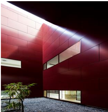
Figure 77 : cour de centre Hicham A. Alsager a Kuwait Source : archidaily
