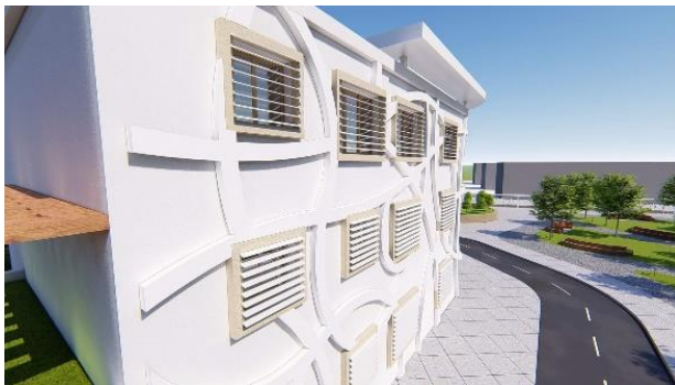
Figure179 : vue présente les brises soleil des fenêtres de l'annexe
