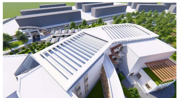
Figure171 : vue présente la double toiture
