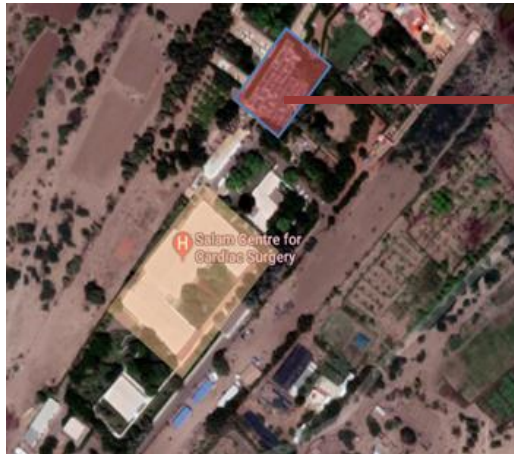
Figure 55 : vue aériennes des panneaux solaires de centre Salam
