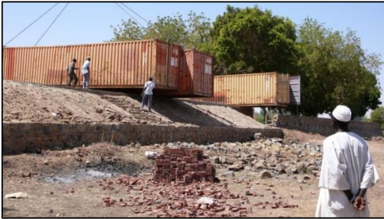
Figure 52 : l'installation des conteneurs Source : rapport 2013 par Hanif Kara
