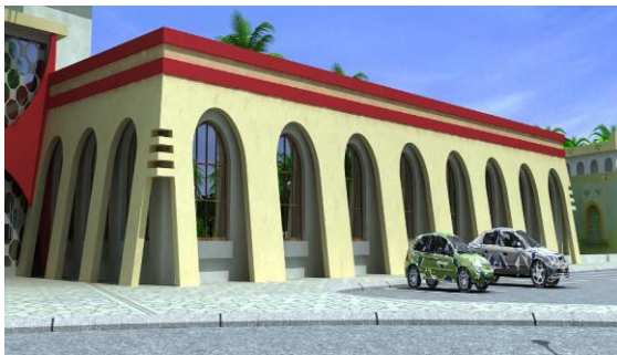
Les galeries inclinés résultat d'assemblage entre les arcades et les contreforts
