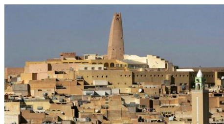
Figure 82 : LE MINARET DE GHARDAÏA SOURCE : AUTEURS
