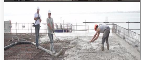
Figure 38 le chantier de Balaruc-Les-Bains, SOURCE :www.thermesbalaruclesbain
