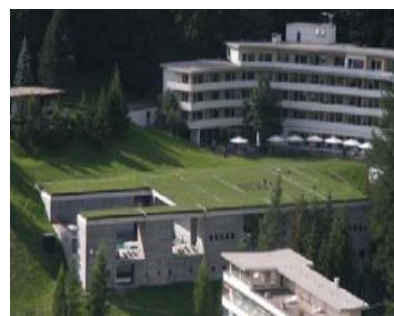
FIGURE 57: VUE EXTERIEUR DES BAINS SOURCE : WWW.VALSARCHITERMA.COM
