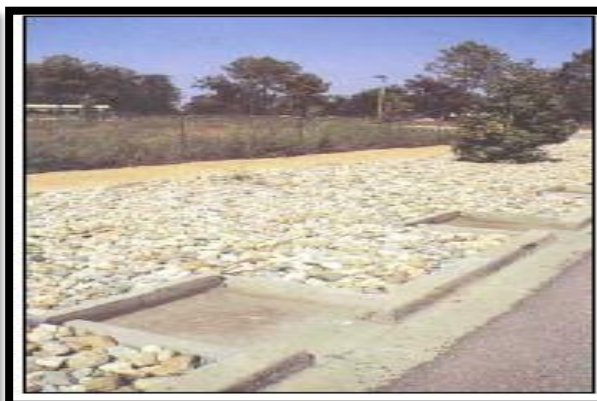
Figure 93 :Photo représente le cas d'un Tranchée d'infiltration, Source :Guide de gestion des eaux de pluie et de ruissellement, 2006
