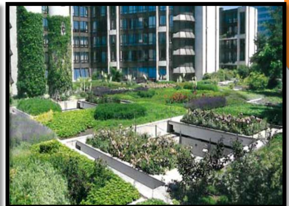
Figure 103 : Photo représente la toiture végétalisée, Source : Guide de gestion des eaux de pluie et de ruissellement, 2006
