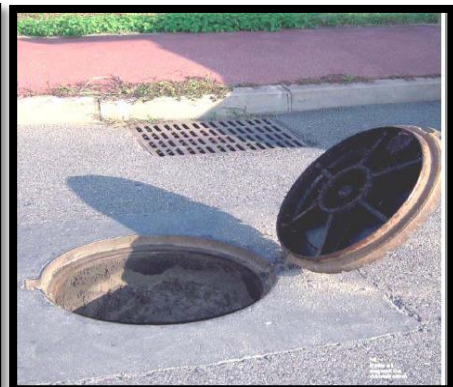
Figure 95 : Photo représente le puits d'infiltration, Source : Guide de gestion des eaux de pluie et de ruissellement,
