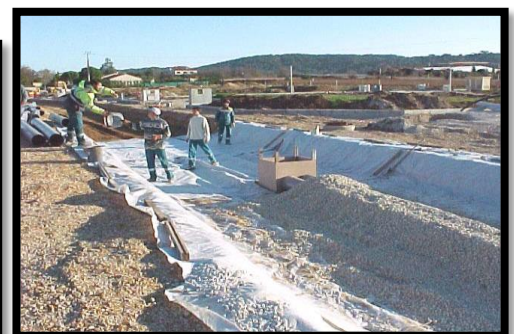
Figure 97 : Photo représente la structure réservoir, Source : Guide de gestion des eaux de pluie et de ruissellement, 2006
