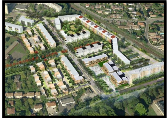
Figure 19: Le quartier après la requalification. Source : http://www.revelarchi.com/nos-projets/ecoquartier-arago-pessac/ .
