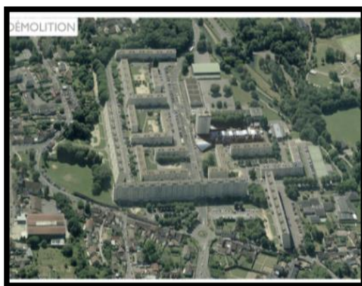
Figure 27: Le projet avant la démolition. Source : https://www.arval-archi.fr/project/npnru-
