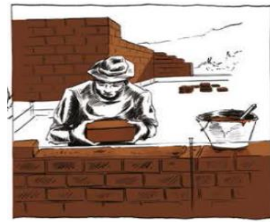
Figure 43. les adobes sont maçonnées à l'aide d'un mortier de terre sur un soubassement
