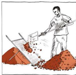
LORS DE SA PRÉPARATION, LA TERRE EST BRUÉE ET TAMISÉE POUR OBTENIR UN MATÉRIAU PULVÉRULENT, HUMIDE ET HOMOGÈNE.
