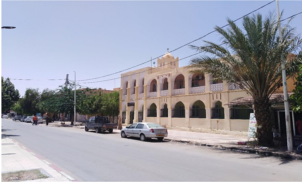
Figure 16 Vue la galerie extérieure.
