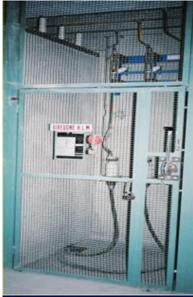
Figure I-11: Cellule postes AIS (ouverts).
