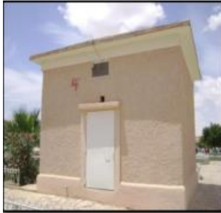
Figure I-3 :Génie civil poste de distribution publique.
