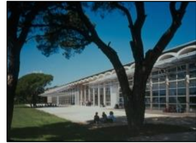
Figure 18: vue sur l'entrée lycée Albert camus
