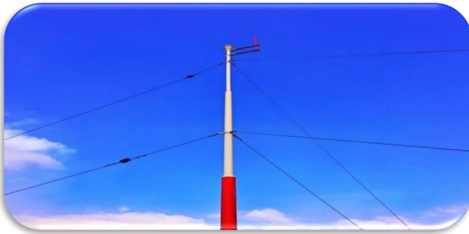
Figure I.5 : capteur de vent [5]
