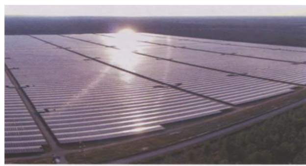
© Gimball Prod / Neoen Centrale PV au sol de 300 MWc (33 Cestas) - Source : notre-planete.info
