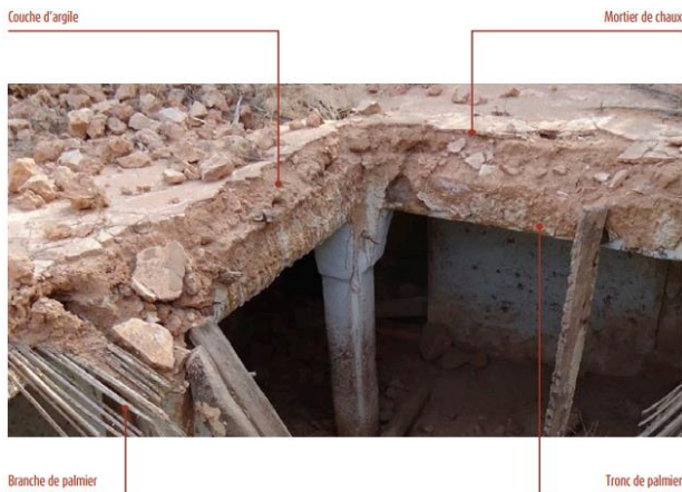
photo 3-16 coupe dans d'un plancher plat ,OPVM
