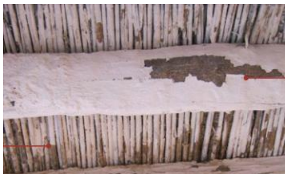
photo 3-18 Plancher avec des roseaux, Source : opvm
