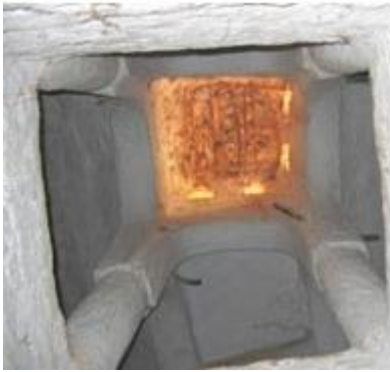
photo 3-4 Coupole de forme carrée dans une habitation traditionnelle Vue interieure et exterieure. Source :OPVM
