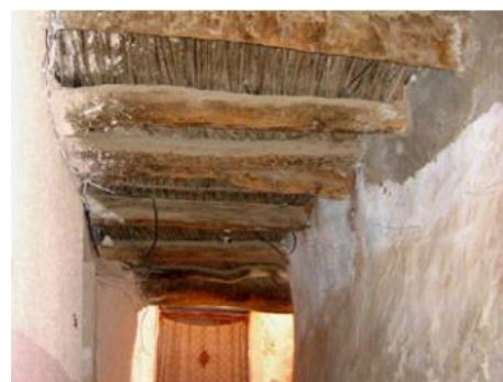
Photo 3-19 planché en vouîtains
