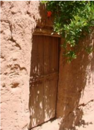
photo 3-22 Linteau en tronc d'arbre à l'entrée d'une habitation Source OPVM
