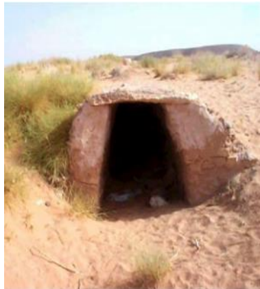
Photo 3-23 Pierre plate utilisée dans le dallage d'un canal de crue source opvm
