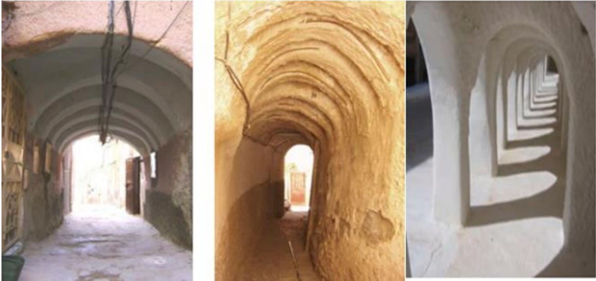
photo 3-5 Passages couverts en arc, à l'intérieur du ksar .Source : OPVM
