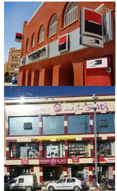
Photo 10 façade en Alucobande, Source : Auteur
