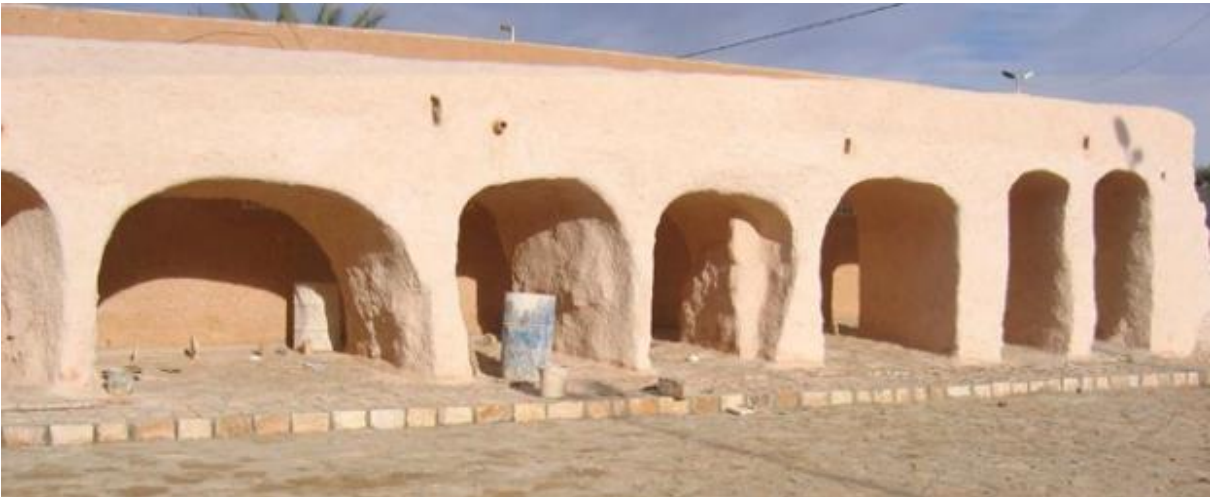
photo 3-15 Utilisation des voûtes au déversoir de Salem-Ouaïssa – Ghardaïa Source : OPVM
