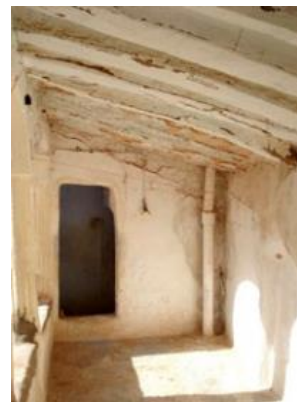
photo 3-21 Plancher incliné d'Ikomar, construit en troncs de palmiers.Source :OPVM
