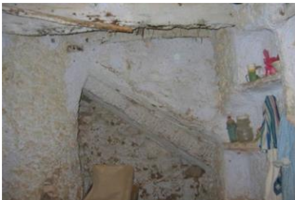
Photo 3-20 Plancher d'escalier porté sur troncs de palmiers.Source :opvm
