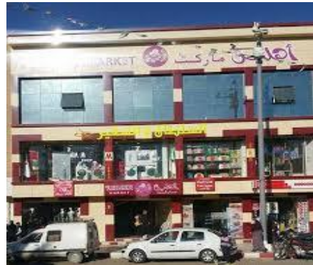
photo 3-13 centre commercial, Source :Auteur
