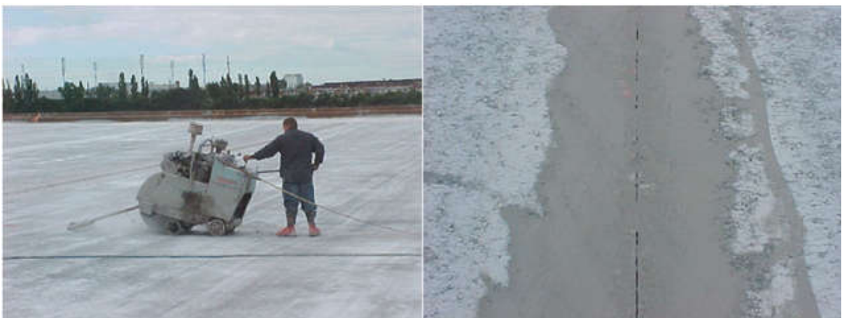
Figure 4.6 : Exécution de joints par sciage après mise en place du BCR - aire Industriel - Montréal [12]
