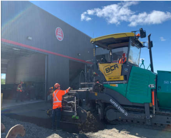
Figure 1.8: Aire d'entreposage du bois en BCR - Papeterie DOMTAR Québec [8]
