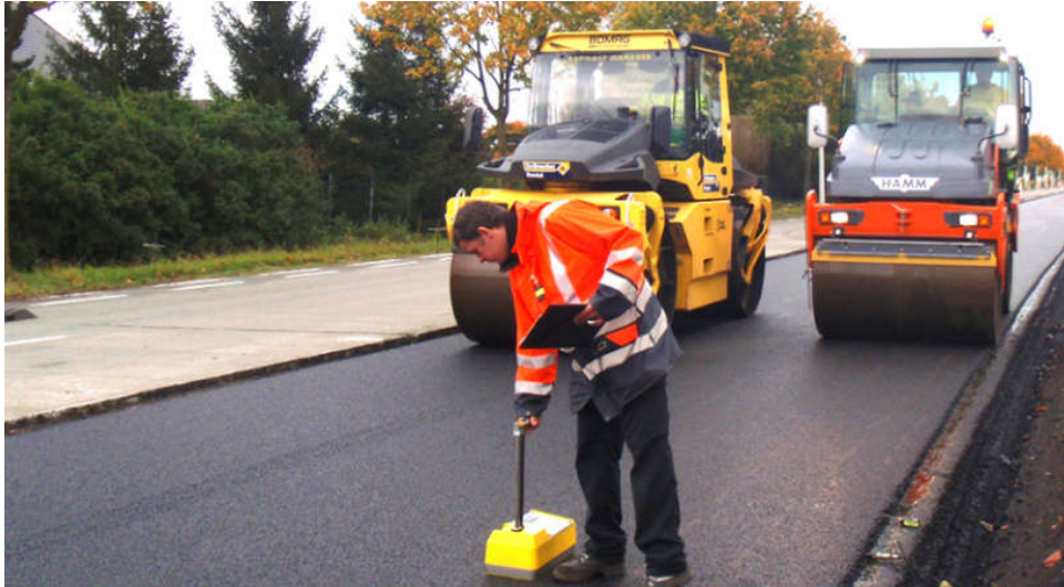
Figure 4.7 : Contrôle du compactage [12]
