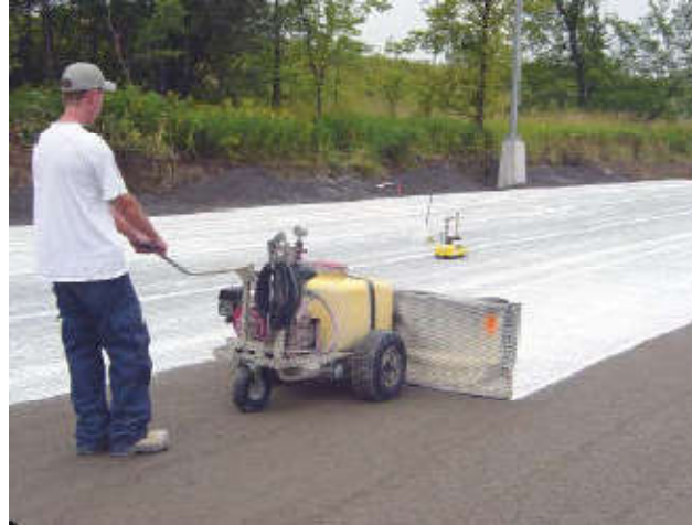
Figure 3.12 : Application d'un produit de cure après compactage du BCR
