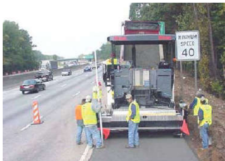
Figure 1.6 : Mise en place du BCR en pavage - Atlanta USA [8]
