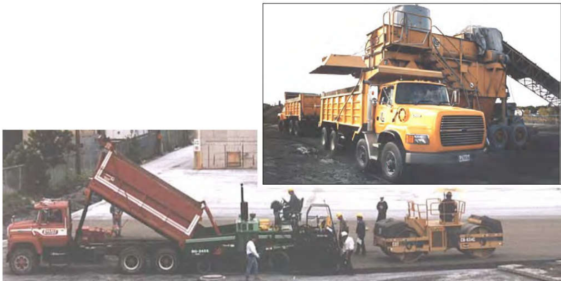
Figure 1.1 : Production et mise en œuvre du BCR
