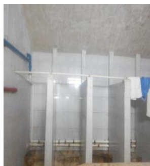
Photo. II.21. La salle chaude Source : auteur
