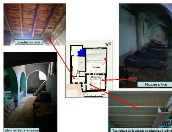
Plancher. I.11. Identification des type de plancher du hammam. Source th se de magister, patrimoine socio-culturel(41)
