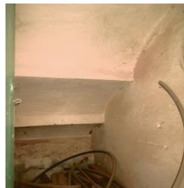
Photo. III.16. L'arrière d'escalier. Source : auteur
