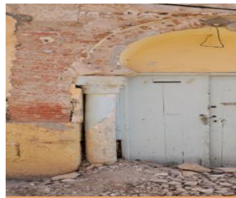
Photo. III.12 . Mur en Brique rouge cuite Source : auteur
