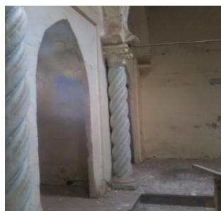
Photo .IV. 11. la détérioration de peinture sur des colonnes Source : pris par auteur.
