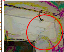
fissures obliques au niveau du murs
