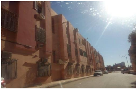
.Photo. II.4 Cité 5 juillet. source : auteurs
