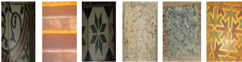
Photo. III.7. Détail du revêtement mur et sol du hammam 'EL-SAADA'.
