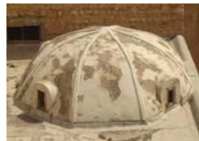
Photo. I.8. Extrados de la coupole. Source :Drioueche-DjaalaliNadjiba-Kheira
