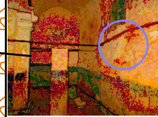
-l'humidité au niveau de voûte et les parois . -fissures obliques au niveau de voute -la corrosion des éléments en aciers (les vannes ...)
