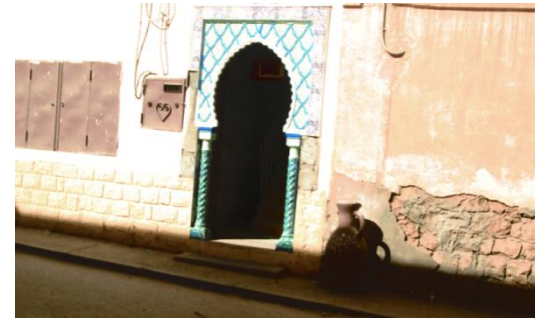
Photo. II.17 l'entrée principale Source : auteur
