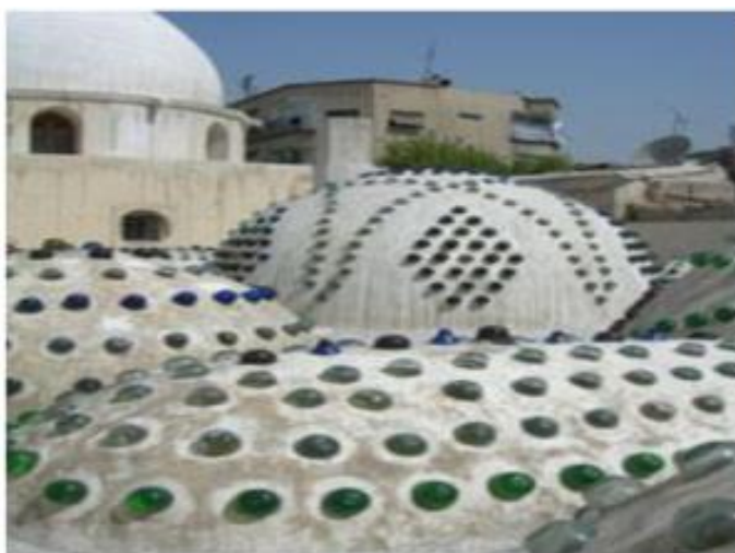
Photo. I. 5 Les coupoles du bain "Al-Tawrizi" éclairage par des « culs-de-bouteilles ». Source : http://www.cigalemag.com . Consulté le 11.11.2017
