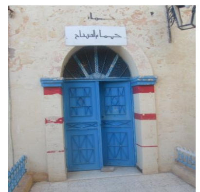
Photo. II. 23. L'entrée principale Source : auteur
