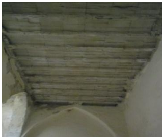
Photo .IV. 9. Détérioration d'enduites photo .IV. 10 . La corrosion d'IPN Source : pris par auteur
