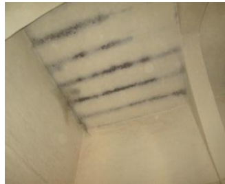
Photo .IV. 9. Détérioration d'enduites photo .IV. 10 . La corrosion d'IPN Source : pris par auteur
