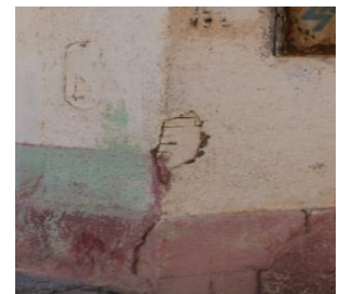
Photo. III.14 .Traitement des angles Source : auteur
