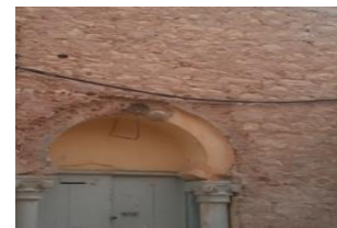
Photo. III. 4. mur en pierre source auteur
