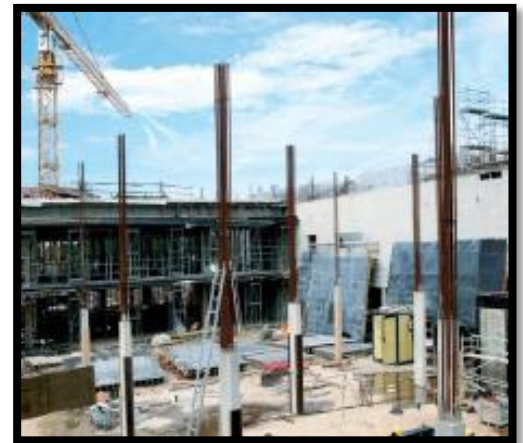
Figure 32: la réalisation de la structure du centre de Luxembourg .Source : IDEM
