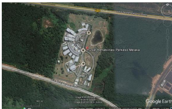
Figure 35 :vue aerien de socso réhabilitation
