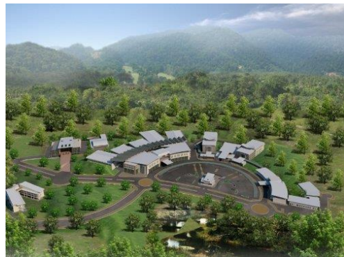
Figure 34 : vue de socso réhabilitation centre
