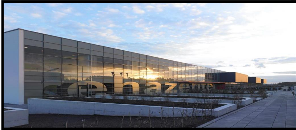
Figure 22:vue en 3d de façade principale Source : Source : http://miesarch.com/work/1251
