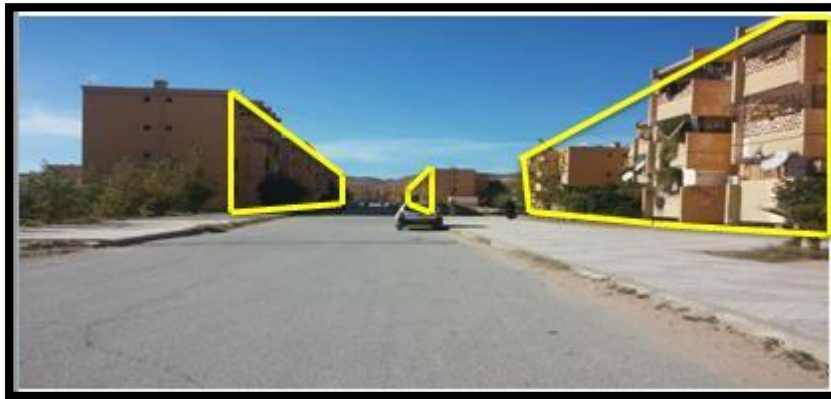
Figure 38 : la voie tertiaire du quartier 500 logements : source : prise par les auteurs
