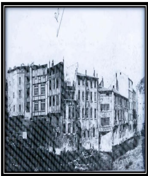
Figure15: bâtiments avant la réhabilitation Source: http://www.tetedoie.com/réhabilitation.htm
