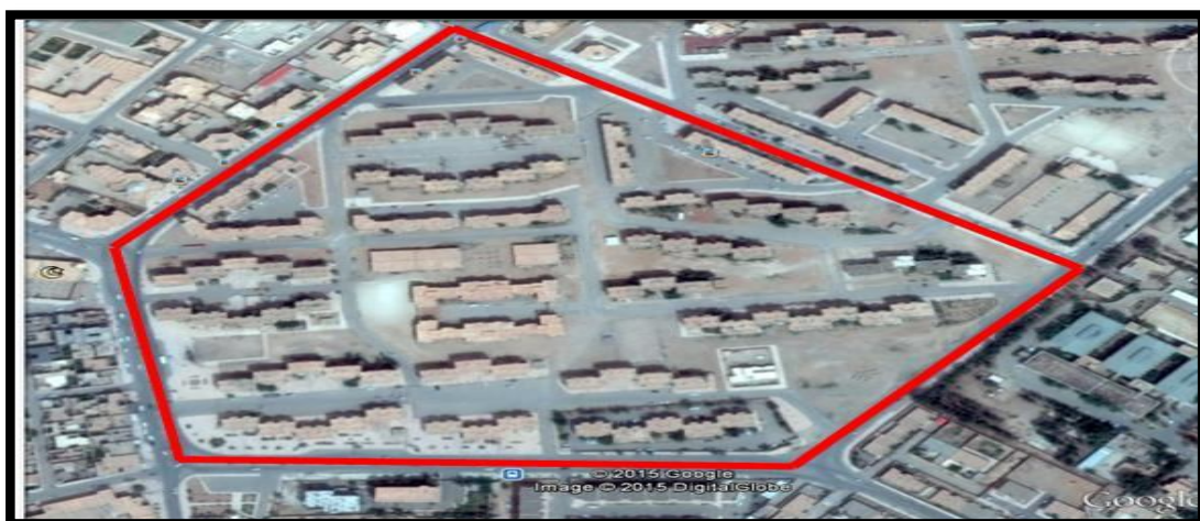
Figure 45: la construction de quartier 500 logements : source : Google-earth traité par les auteurs
