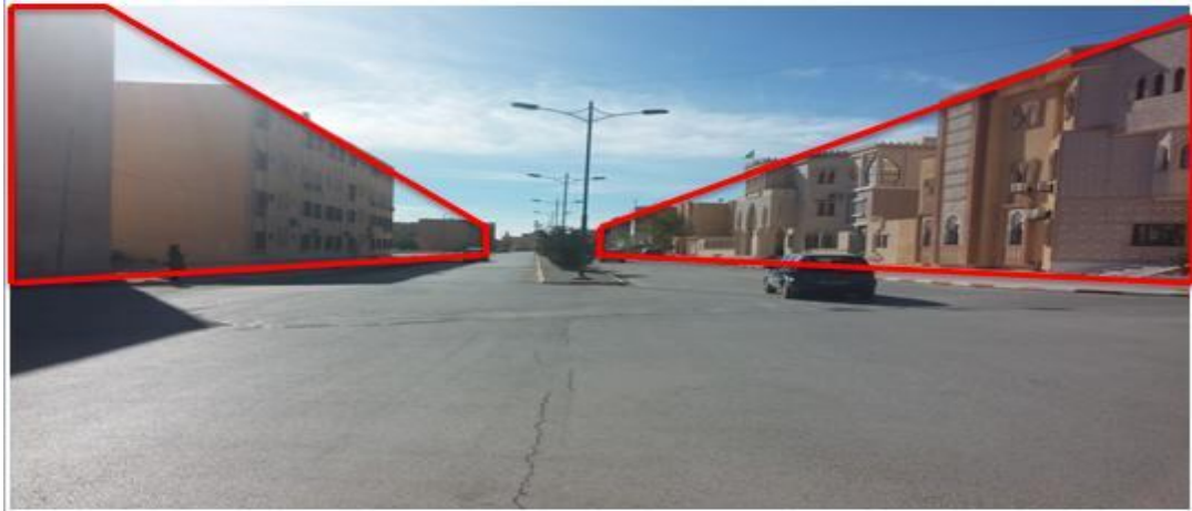
Figure 34 : la voie principale N1 du quartier 500 logements : source : prise par les auteurs
