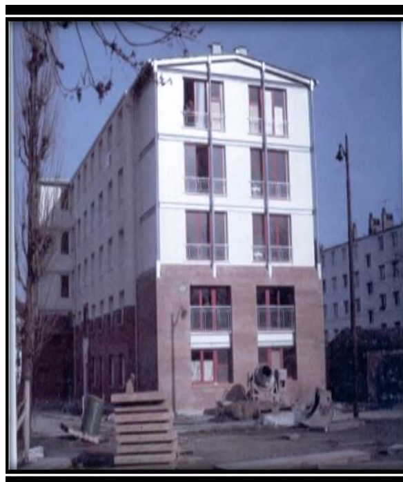
Figure 18 :Réhabilitation d'une façade (après) Source; http://www.tetedoie.com/réhabilitation.html
