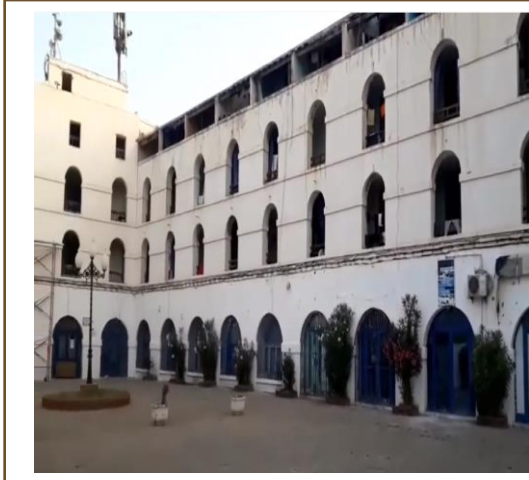
الشكل 25: الفصل النظري: صورة توضح استخدام مبدأ الحوش في مركزية الكتل المعمارية المصدر: الصفحة الرسمية للمجمع
