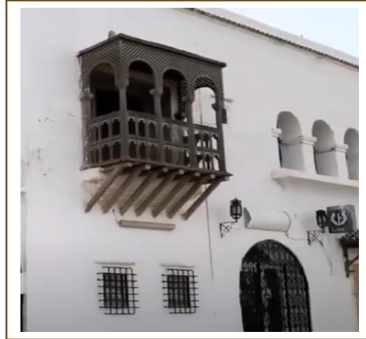
الشكل 26: الفصل النظري: صورة توضح استخدام المشربيات المصدر: مقتطف من فيديو حالة مجمع سيدي فرج السياحي
