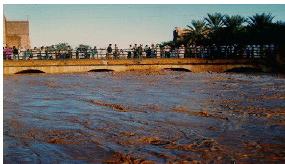
Fig.4.5. Le niveau d'eau a atteint 9m en 2008
