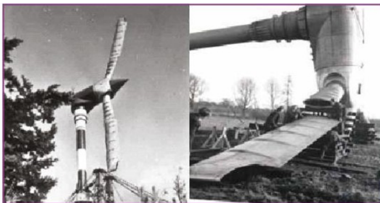
Figure 1.10 Photo d'une éolienne de 100 kW de Grand Vent installée en Algérie en 1957
