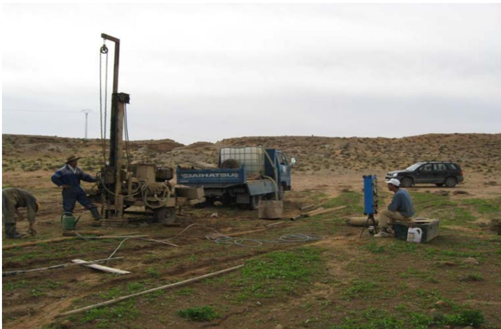
Figure III.8 : Matériel pour sondages pressiométriques.
