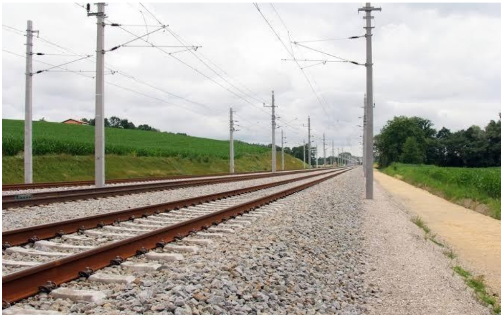
Figure I.17 : Couche de ballast.
