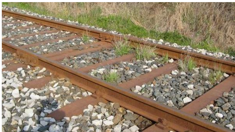
Figure I.14 : Traverses métalliques.
