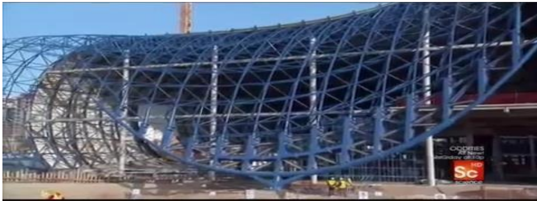
Fig : système de récupération des eaux pluviales avec structure tridimensionnelles Source : www.structure.fr
