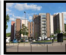
Fig. 32 : logements avant la réhabilitation. Source : https://www.youtube.com/watch?v=eytxBiHwgZA
