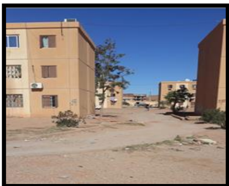
Fig. 72 : voie tertiaire dans la cité 1 er Novembre / établie par les étudiantes/décombre 2018
