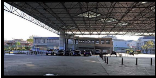
Fig. 09 : suppression de toiture. Source : Torcy, val-Maubuée, marue-la-ballée.pdf/p :04
