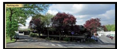
Fig. 08 : démolition de parking de silo. Source : une nouvelle ambition pour l'arche huedron.pdf/ p : 14
