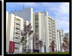
Fig. 33 : logements après la réhabilitation. Source : https://www.youtube.com/watch?v=eytxBiHwgZA
