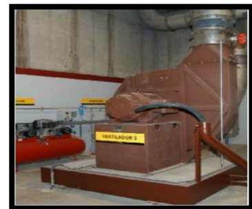
Fig. 05 : Le terminal de collecte. Source : La collecte pneumatique des déchets ménagers : l'innovation au service de l'environnement
