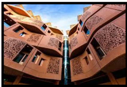
Fig. 47 : façade du bâtiment dans Masdar. Source : https://www.skyscrapercity.com/showthread.php?t=1579144&page=5
