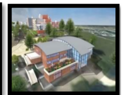
fig. 28 : la maison pour tous après la réhabilitation. Source : https://www.youtube.com/watch?v=eytxBiHwgZA
