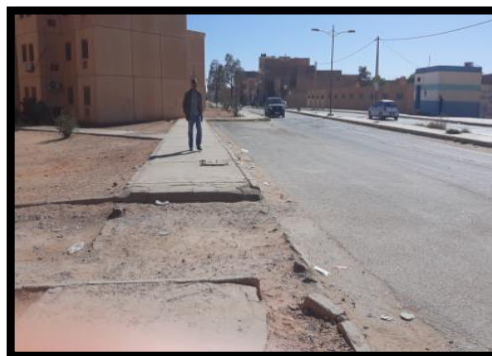
Fig. 73 : voie tertiaire dans la cité 1 er Novembre / établie par les étudiantes/décombre 2018
