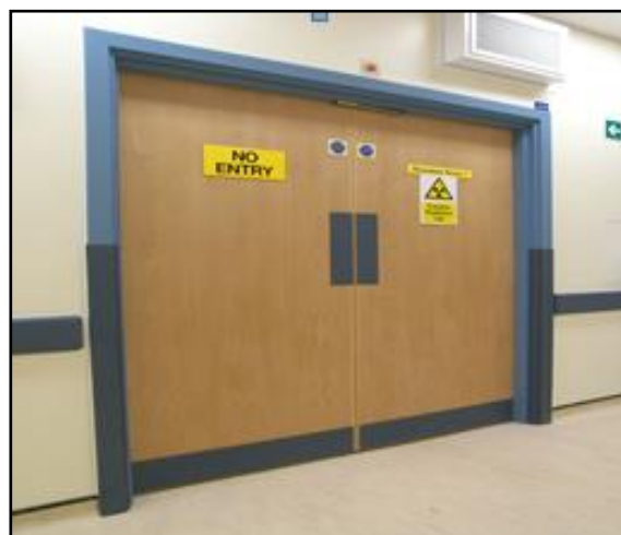
Figure 246 : Le porte plomb anti rayonnement http://www.medicalexpo.fr/prod/envirotect/product-78385-479935.html
