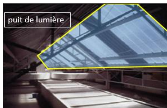
Figure 87:la toiture de center la source: bioclimatique centre hospitalier(Murcia Espagne).pdf
