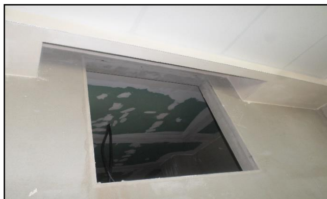
Figure 233: faux plafond fixe en plaque de plâtre hydrofuge 240 lits à Laghouat
