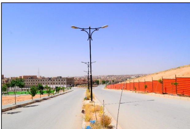
Figure 124:vue sur la voie principale la source: l'auteur
