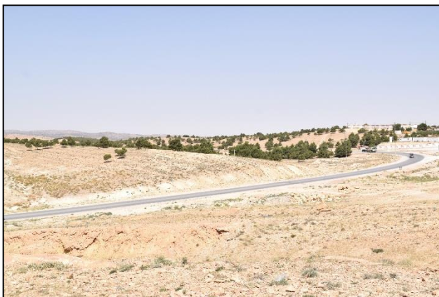
Figure 122:la voie tertiaire la source: l'auteur
