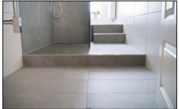
Figure 237: Revêtement sol en grès cérame pour locaux humide
