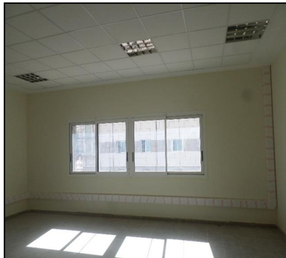
Figure 248 : fenêtre en aluminium. Hôpital 240 lits. Laghoutat source : auteur
