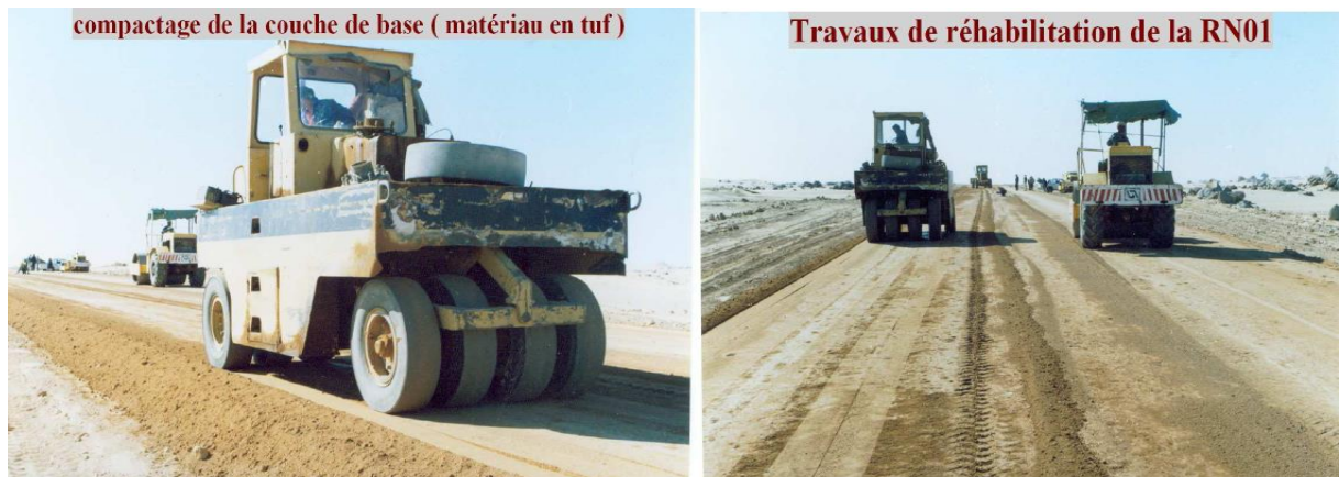
Figure 11 : Renforcement de la RN01 entre Tamanrasset - In Guezzam (Sebaa, 2006).
