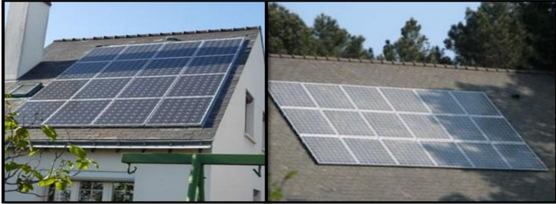
ظل البنايات و المدخنات
