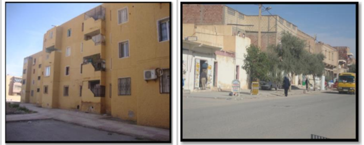
صورة رقم (14) : توضح التضاد في الواجهات والاختلاف في نمط البناء المصدر : من التقاط الطلبة
