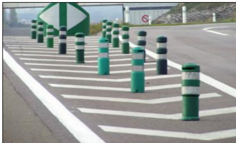
Figure II.24 : Type de balise Balisage des îlots séparant deux courants de trafic de même sens
