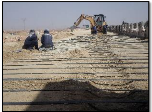
Figure II.12 : Mur en terre armée
