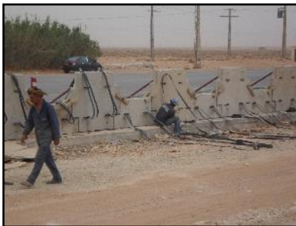
Figure II.12 : Mur en terre armée
