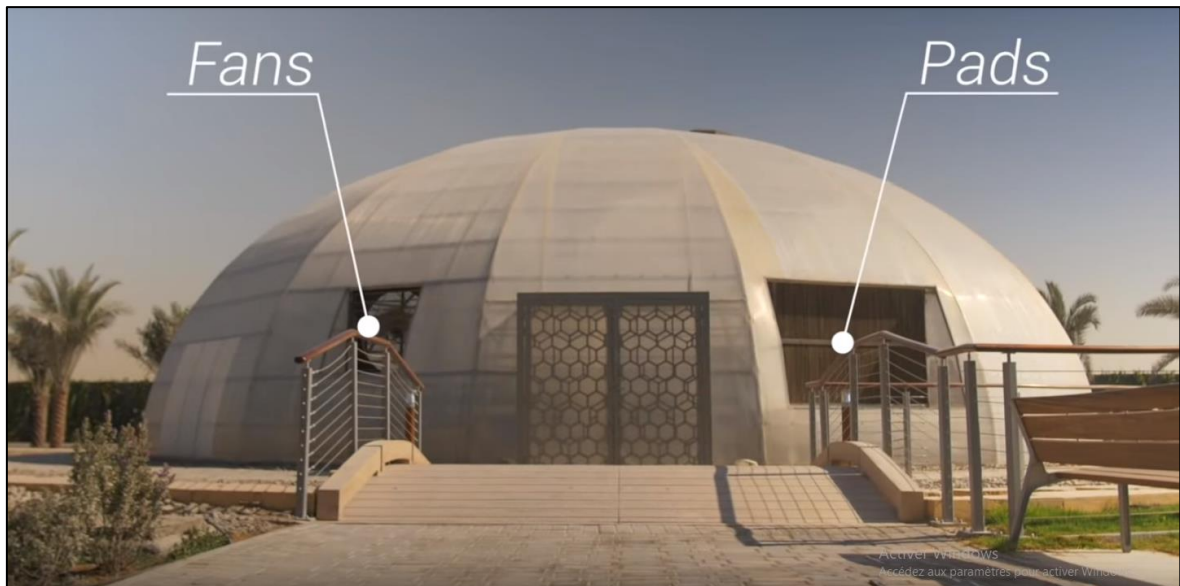
Photo 16 la mise en sous-pression par les extracteurs force l'air frais d'entrer dans la ferme, de 45° la température passe à 30° à l'intérieur.
