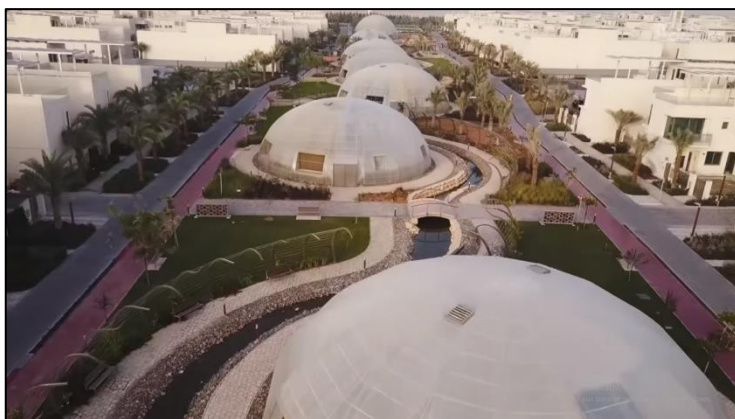
Photo 12 cours d'eau passant sous les fermes
