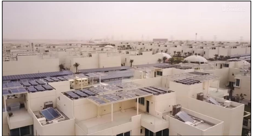
Photo 7 villas avec panneaux solaires
