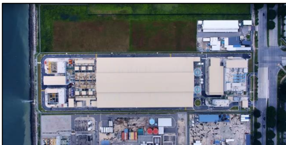
Photo 56 elle ne fait que 100 x 300 m la moitié de la surface des autres usines de dessalement d'eau dans le monde
