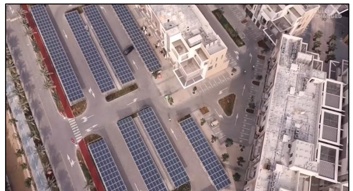
Photo 9 vue aériennes sur les parkings
