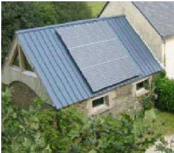
Photo7 :Intégration des panneaux photovoltaïques sur Une partie de la toiture en pente
