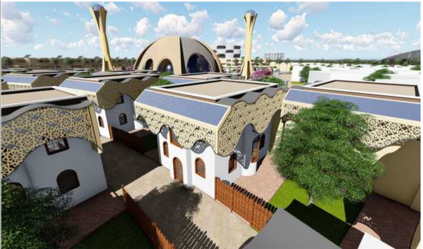
Photo21: Intégration des panneaux photovoltaïques en auvent et brise soleil sur ouvertures
