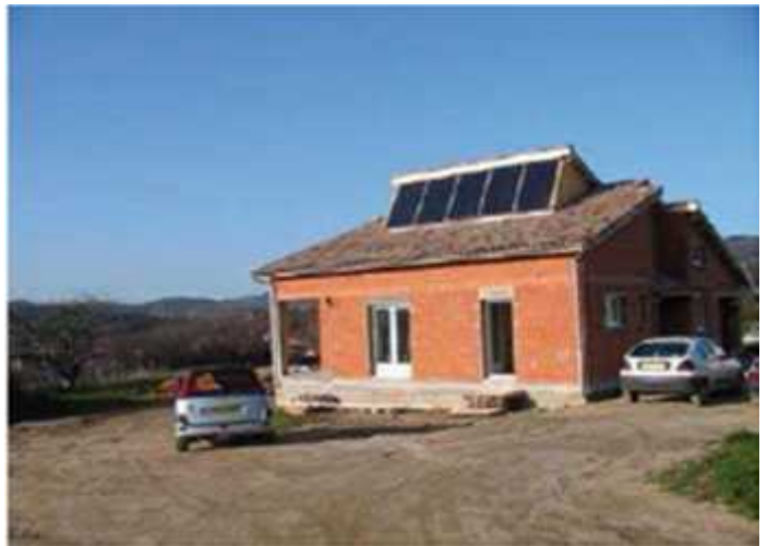
Photo8 :Intégration des panneaux photovoltaïques sur une toiture en pente d'un volume
