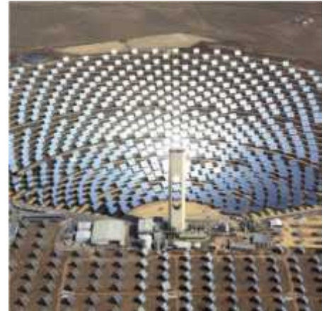
Photo2 : Centrale solaire thermique pour production d'électricité (150 MW) (Boutarfa, Algérie)
