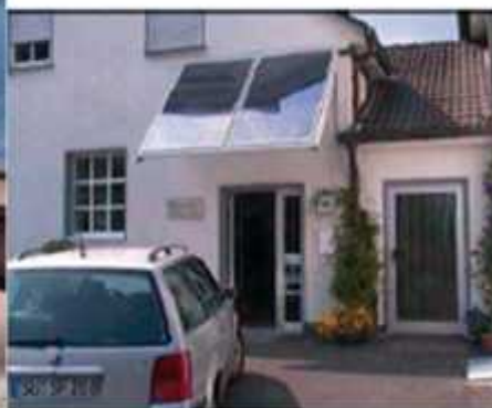
Photo10 :Exemple d'installation des panneaux photovoltaïques en auvent d'une ou brise soleil
