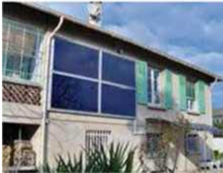
Photo11 :Intégration des panneaux photovoltaïques sur la façade comme composant architectural
