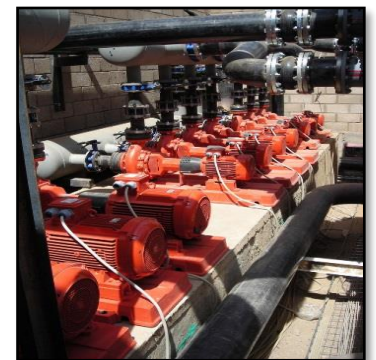
Figure 60 : appareils de refroidissement source : archidaily.com
