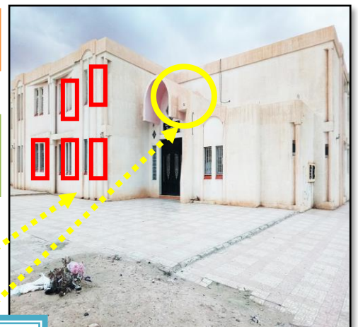
Figure 85 : façade école primaire, source : auteur
