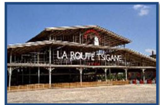
Figure I-47: Grande Halle source: wikipédia.org
