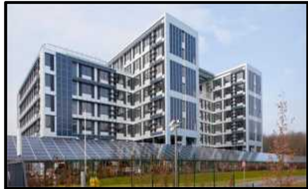
Photo03 : Immeuble de bureau green office Source : Archdaily (www.Archdaily.com).
