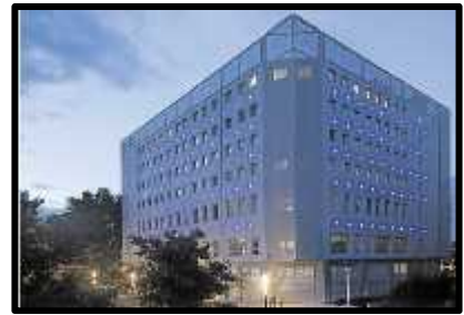
Exemple 03 : immeuble EDF - Lyon-France -
