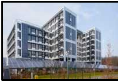
Exemple 02 : immeuble de bureau de green office - Meudon-France -
