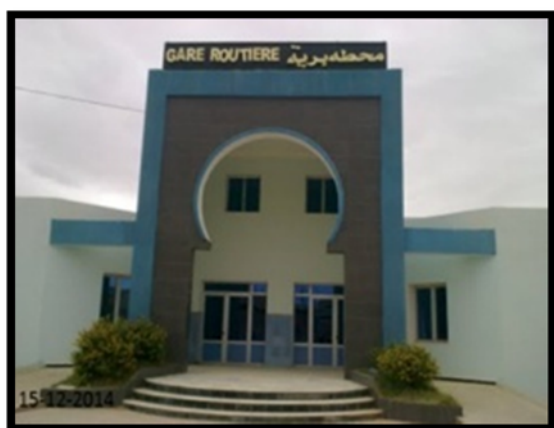
Figure 88 : Gare routière d'Ain-Ouessara [Source : prise par auteurs]
