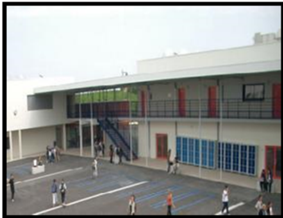
Figure 31 : Vue sur la façade intérieure Source : Mémoire fin de formation en HQE. Claire Martin. Ecole d'architecture Lyon .2006
