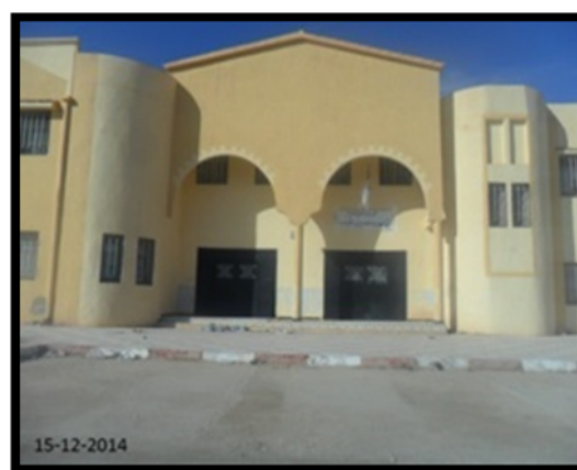
Figure 89: Ecole Omran Tayeb a Ain-Ouessara [Source : prise par auteurs]
