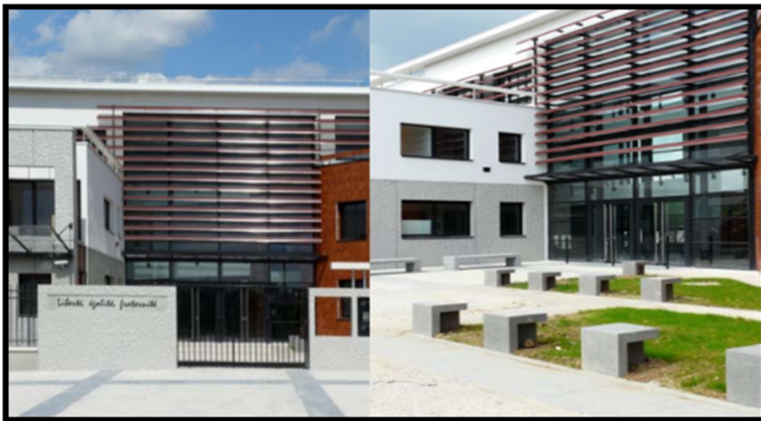
Figure 62 : façade sud-ouest (Store a lame orientable) [Source : http://www.Atlas des colleges.com ]
