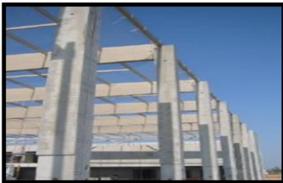
Figure 108: ossature en béton armé [Source : http://www.calcia-infos.com ]
