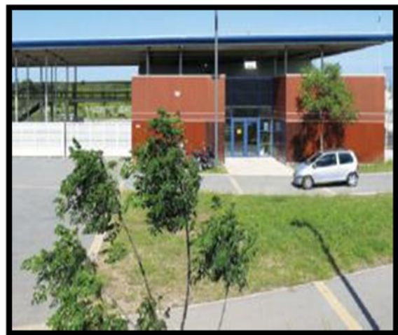
Figure 23: Entrée principale du collège Pierre Deley [Source : QE. Département hérault.2009 ]
