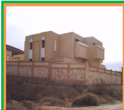
Fig.II.10 : Un nouvel habitat semi-collectif(R+1) Source : photo prise par étudiante
