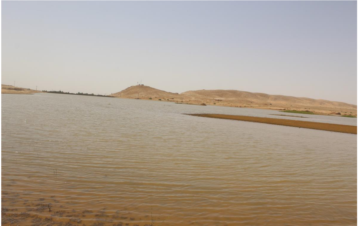
Figure 10 : Vue générale du barrage Lelmaya (Photo originale).
