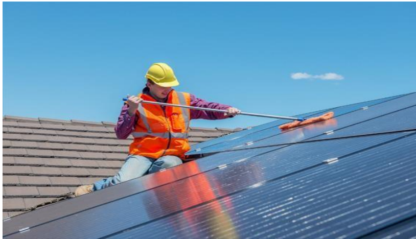
Figure II.25 : Nettoyage des panneaux
