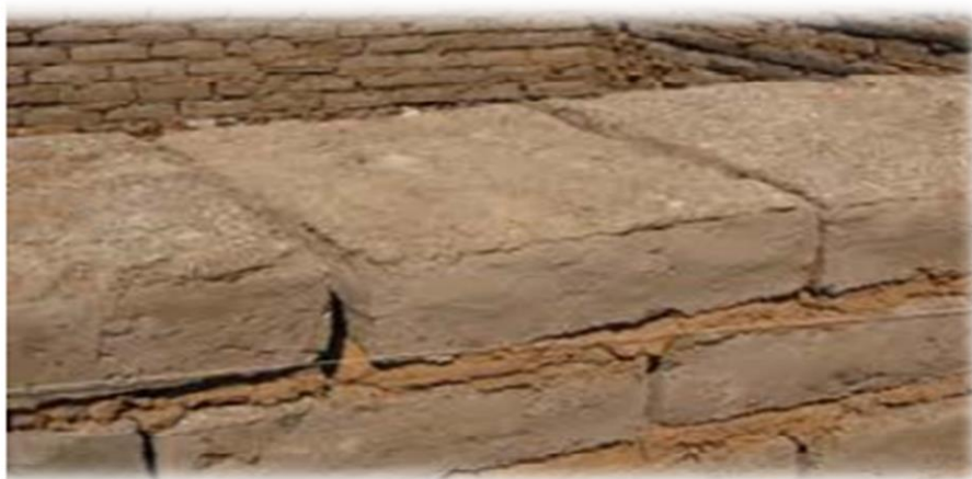
Photo I.4 Mur en adobe déjà monté (Source : Encyclopédie interactive Wikipédia)
