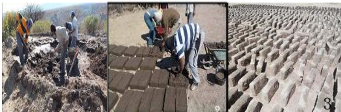
Photo I.3: étapes des opérations adobe ( http://www.cap-a.fr/construction-terre-crue-nouveau-mexique/ ).
