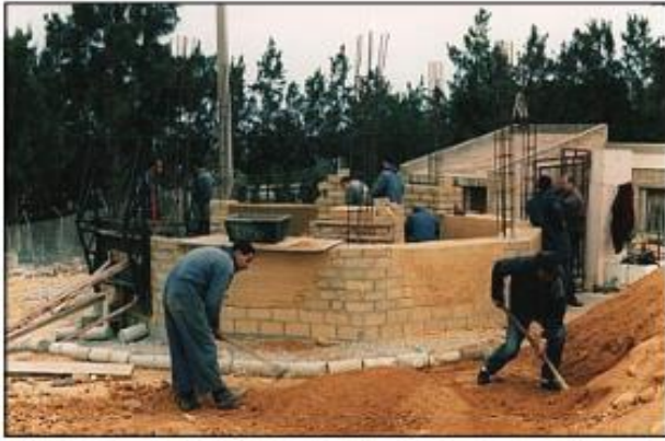
Photo I. 13: Premières assises du prototype de Soudania1999 de (Le CNERIB)
