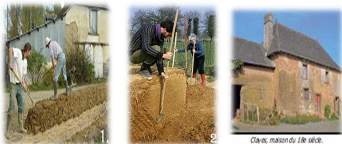
Photo I. 2 : étape de opération Bauge ( http://www.totem-terre-couleurs.fr/maconnerie-terre/mur-de-bauge.php ).
