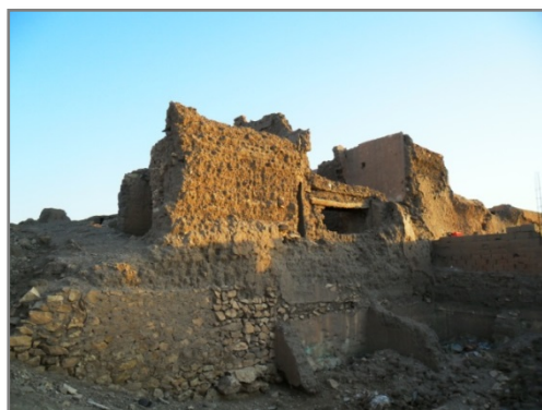
Photo 10 : Maison construite avec la terre. Source : l'auteur.
