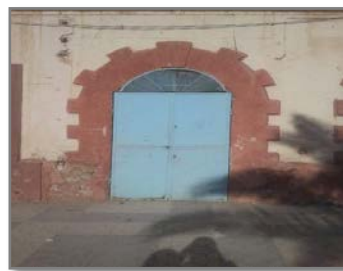
Photo N°28 : Les portes : porte en arc pleine cintre avec des claveaux et une clef d'arc. /Source : Auteur.
