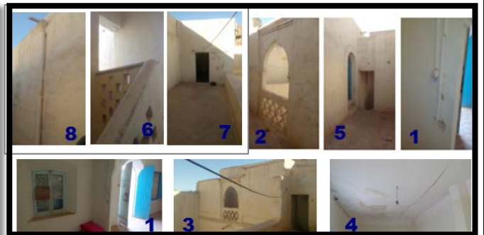
Photo N°25 : Les différentes vues du 1ère étage. /Source : Elaborer par l'étudiante.
