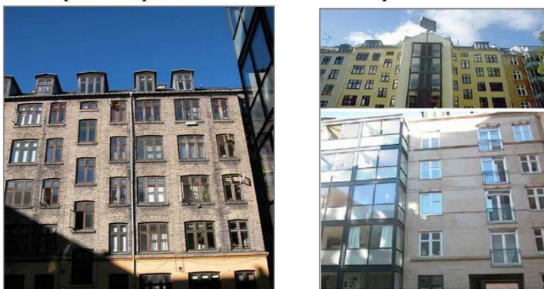
Fig 9 : Les façades des immeubles en cours de réhabilitation Source : PDF le quartier Vesterbro à Copenhague au Danemark.
