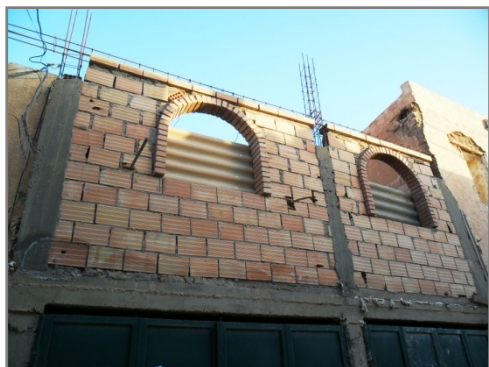
Photo 12 : Façade d'époque coloniale. /Source : l'auteur.
