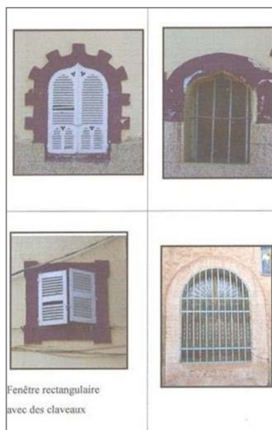
Photo 19 : les fenêtres Source : thèse réhabilitation des espaces publics(boudelaa hadjer gourgab hadjer)
