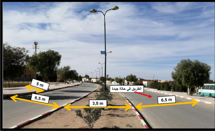
الصورة 34: توضح حالة الطرق المصدر: من التقاط الطالب
