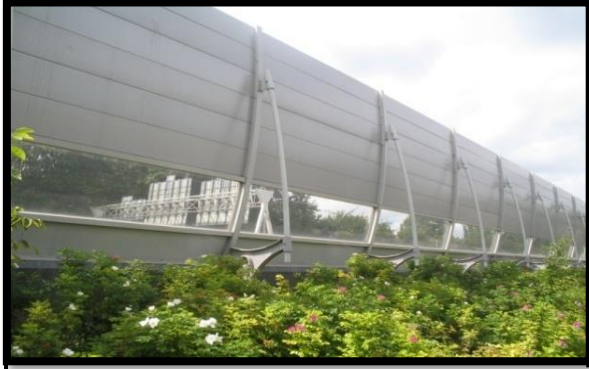
الصورة 05: صورة لمصدات الضجيج بهولندا
