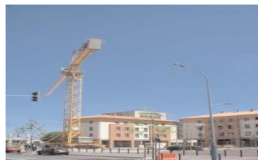
Image n04 : Aménagement d'une nouvelle place publique le long de la rue Desbals Source : https://www.toulouse.fr/web/projet-urbain/-/bellefontaine-presentation/
