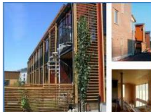
Image N°03: Les matériaux de construction employés.
