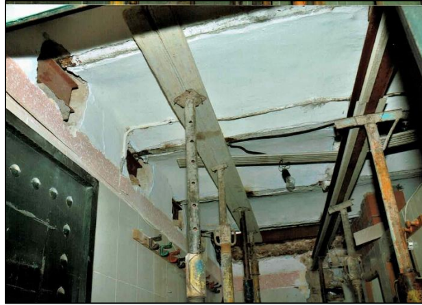
صورة -37- ترميم سقف المطهرة (توظيف الطالب)
