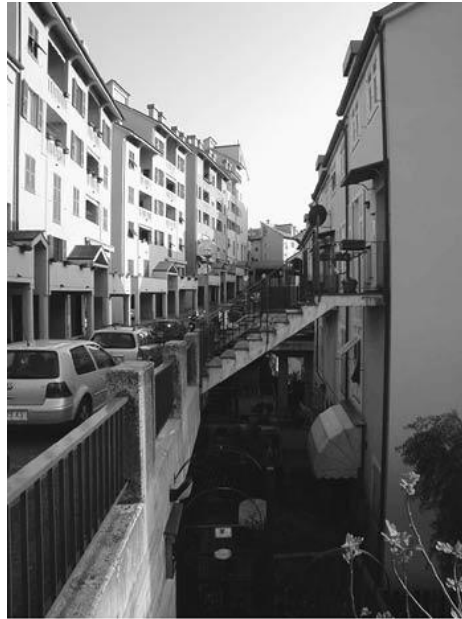
Figure 10- Vue sur la voie carrossable (De Martin, 2009, p. 137)
