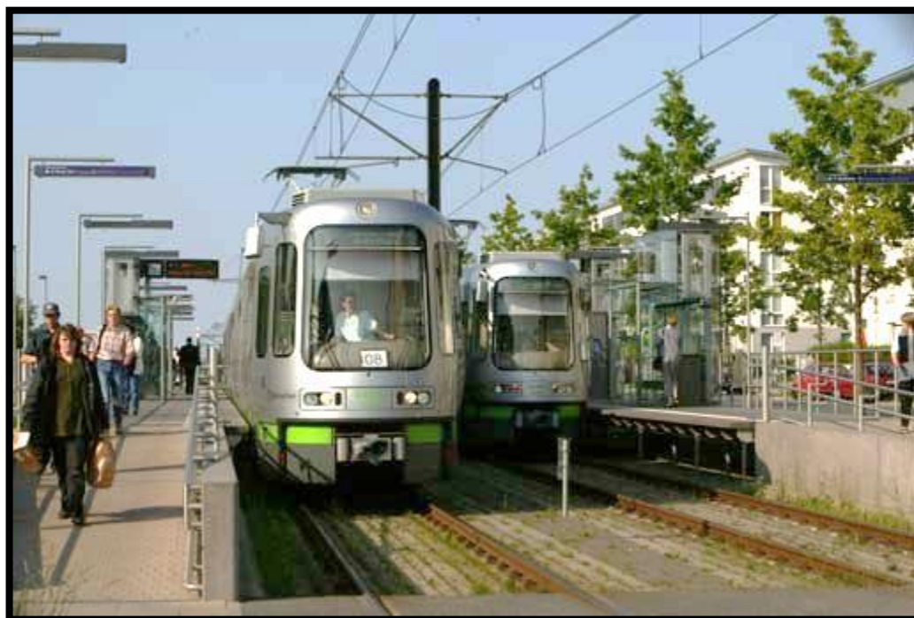
Figure II-9 : L'arrêt de métro « Kronsberg » du quartier KRONSBURG HANOVRE Source : http://www.ecoquartiers-geneve.ch/index.php?page=kronsberg-hanovre
