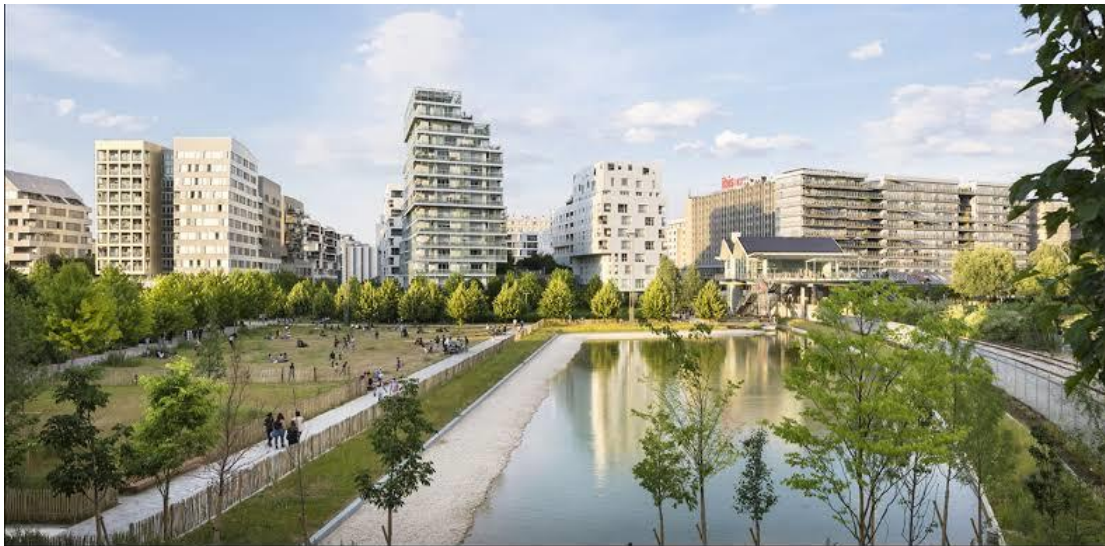
Figure II-42 : bassin d'eau dans le quartier .
