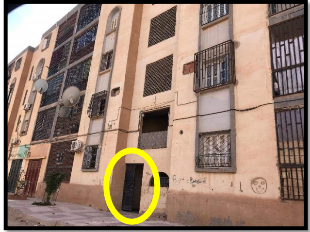
Figure IV-6 Une porte d'entrée invisible Source : prise par l'auteur.
