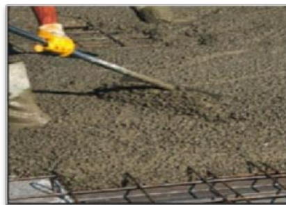
Figure I-5: Le béton de granulats léger
