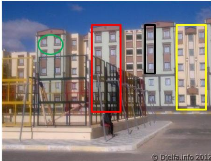
Photo 01 : le style architectural source : auteur
