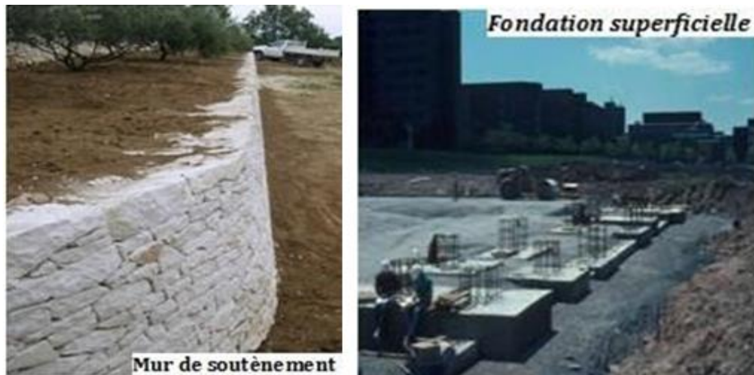
Figure I-2: Exemple -2- des constructions géotechniques. [2]
