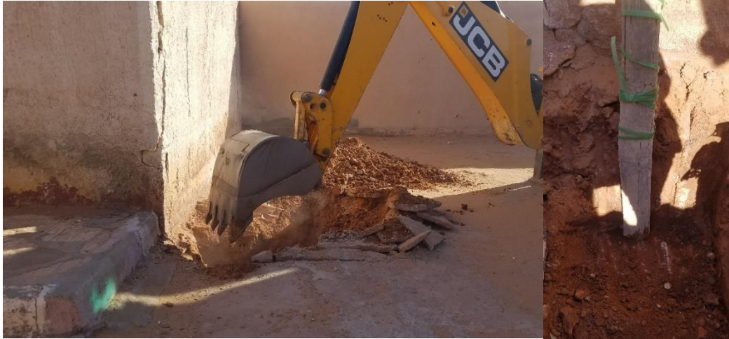
Figure III-11 : Examen du puits de reconnaissance
