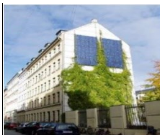
Photo 4 : les cellules photovoltaïques sur les façades
